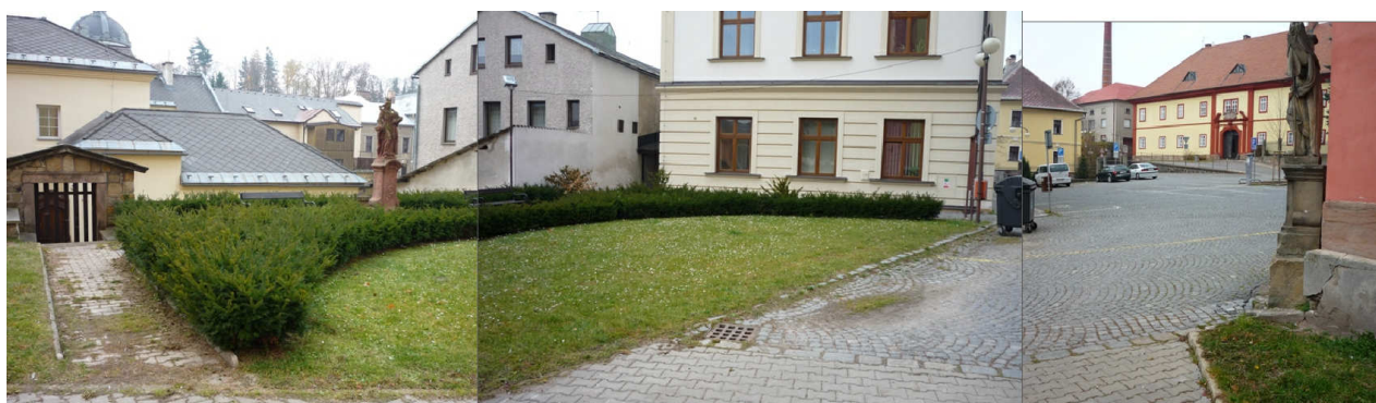
POHLED OD JIŽNÍHO VSTUPU DO KOSTELA NA MĚÚ
